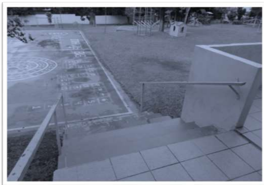
Figura 29 Acesso das salas de aula para o parque: EMEI Hélio Duarte
