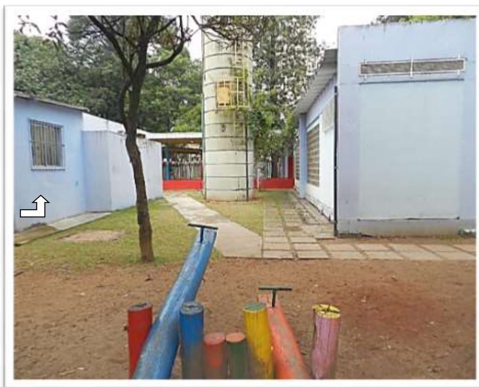
Figura 36 Refeitório dos funcionários – “Casinha da girafa” (à esquerda da foto)
