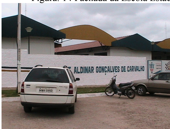
Figura: 14 Fachada da Escola Estadual
