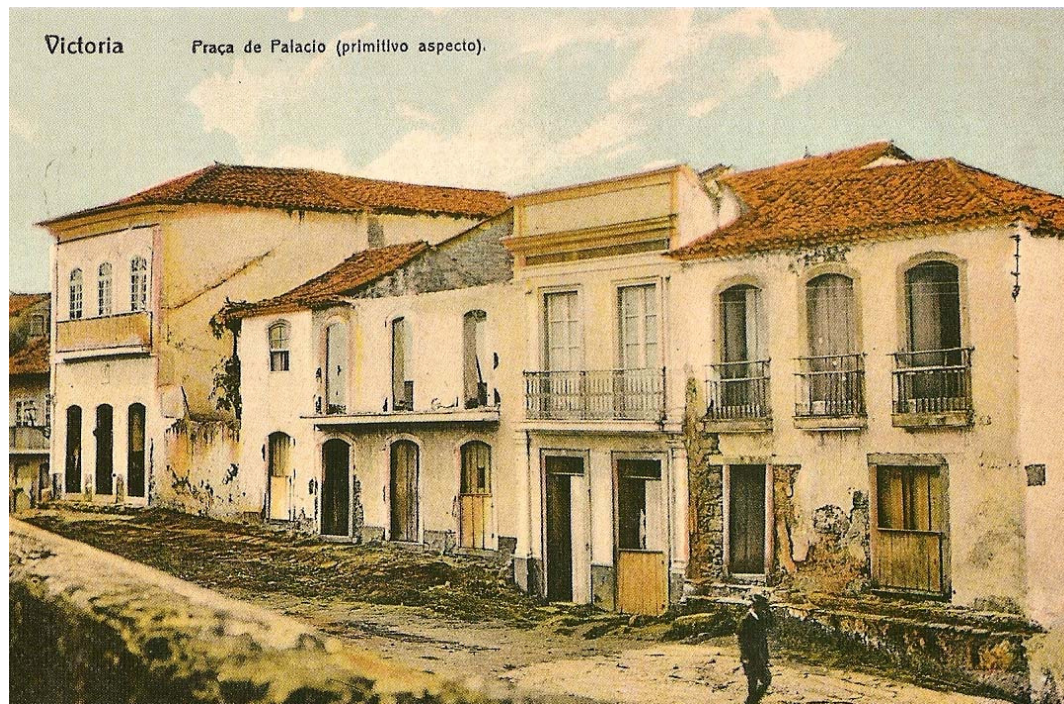
CP 13 - Victoria: Praça do Palácio. Atenta-se para a legenda "primitivo aspecto", fazendo referência a degradação visual. Esses casarões foram demolidos durante as obras de reurbanização da região central da cidade, por volta de 1910. Coleção Belchior. A imagem se torna documento frente às modificações realizadas nos espaços públicos.
