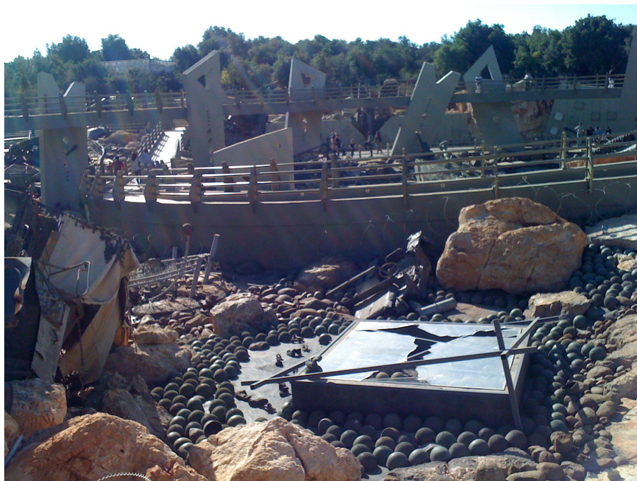
Fig. 75 - Panorama arquitetônico geral do parque.
