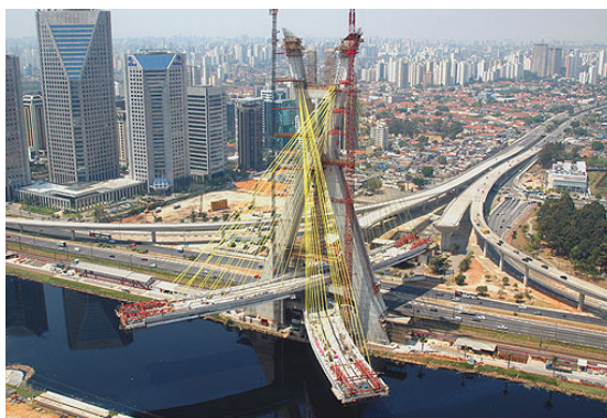
Figuras 38 e 39 Uma das inovações da construção da ponte foi o espaçamento mínimo de 10 cm entre os estais para o inédito entrelaçamento.
