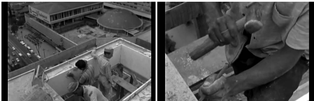
Figura 2: Trabalho na construção civil
