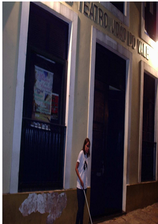
Fachada de teatro sem sinalização em braille
