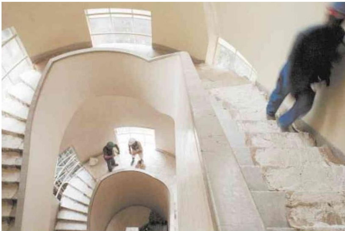
Figura 43 - Reparos sendo feitos para a montagem da CASACOR. 351
