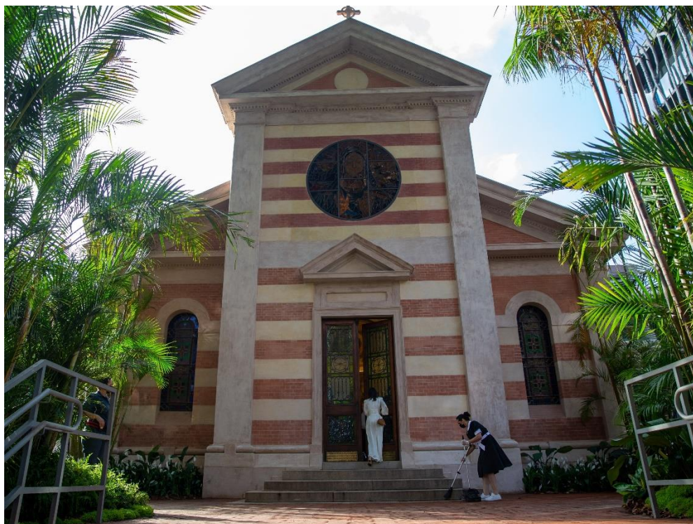
Figura 62 - Fachada da capela Santa Luzia depois do restauro. 420
