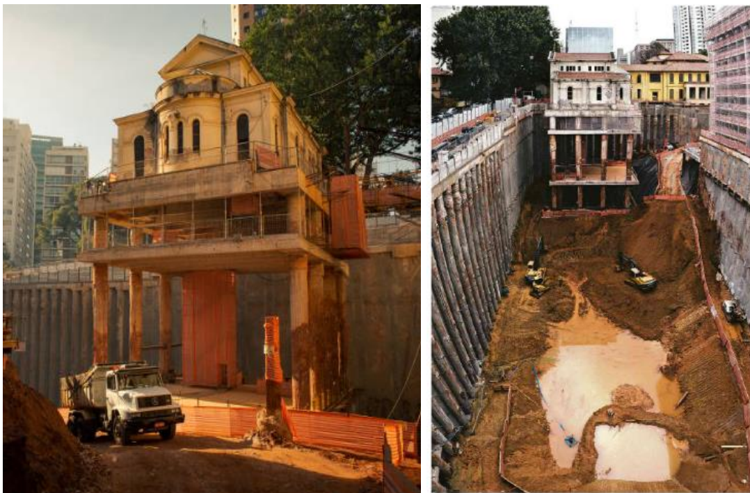
Figuras 59 e 60 - Capela do complexo “suspensa” para a construção dos subsolos. 417
