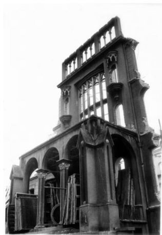
Figura 3. Demolição do Colégio Des Oiseaux - Acervo do Estadão 514
