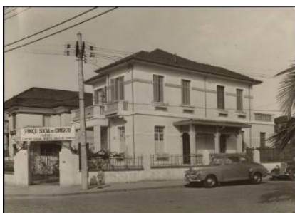
Fachada do Centro Social Bento Pires de Campos, Foto: Agência Vasclo
