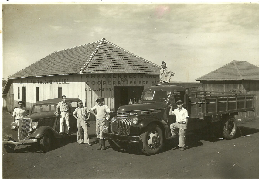
Figura 11. Armazém da Cooperativa.
