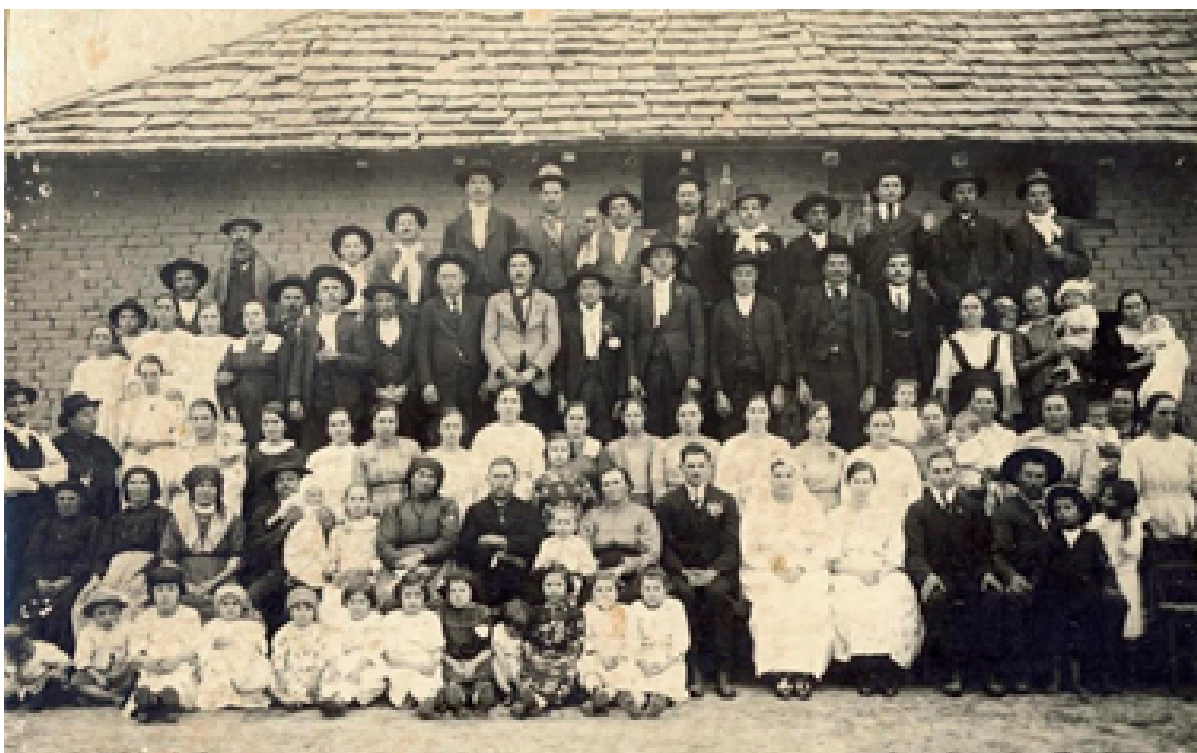
Imagem 9 - Casa de tijolos de barro maciço coberta com tabuinhas de madeira chamadas “scandoles” (1920). 250
