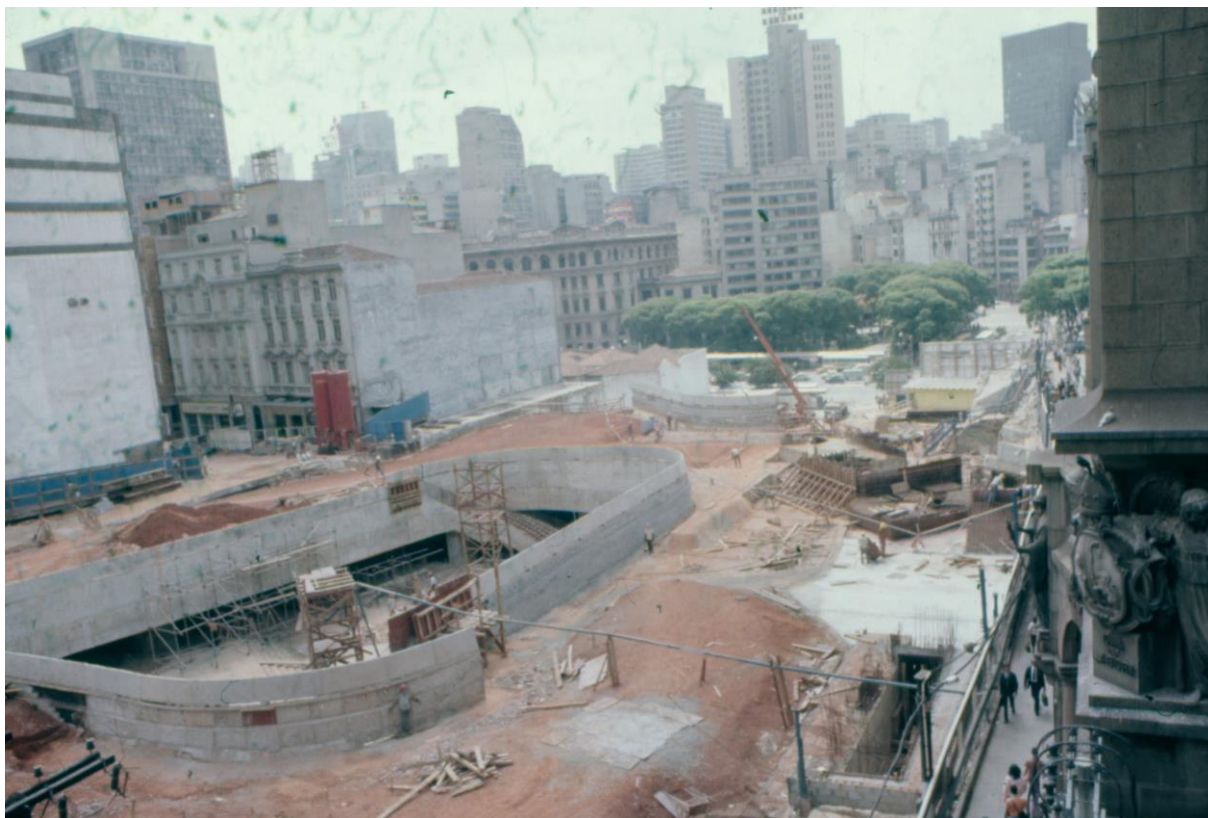
Imagem 36: Estação São Bento. Metrô de São Paulo, década de 1970.
