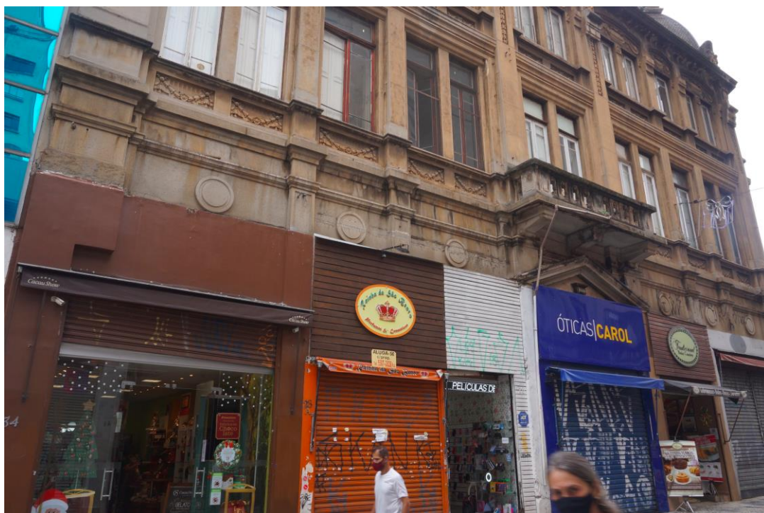
Imagem 4: Fachada meio a meio na Rua São Bento. Foto da autora, dezembro de 2020.
