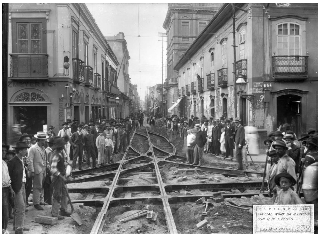
Imagem 32: Obras de assentamento de trilhos no cruzamento da rua São Bento, nesta tomada destacando o trecho em direção ao Largo São Bento, e a rua Direita, em primeiro plano, que formam o famoso 'Quatro Cantos'. Guilherme Gaensly/ACERVO FUNDAÇÃO ENERGIA E SANEAMENTO, abril de 1902.
