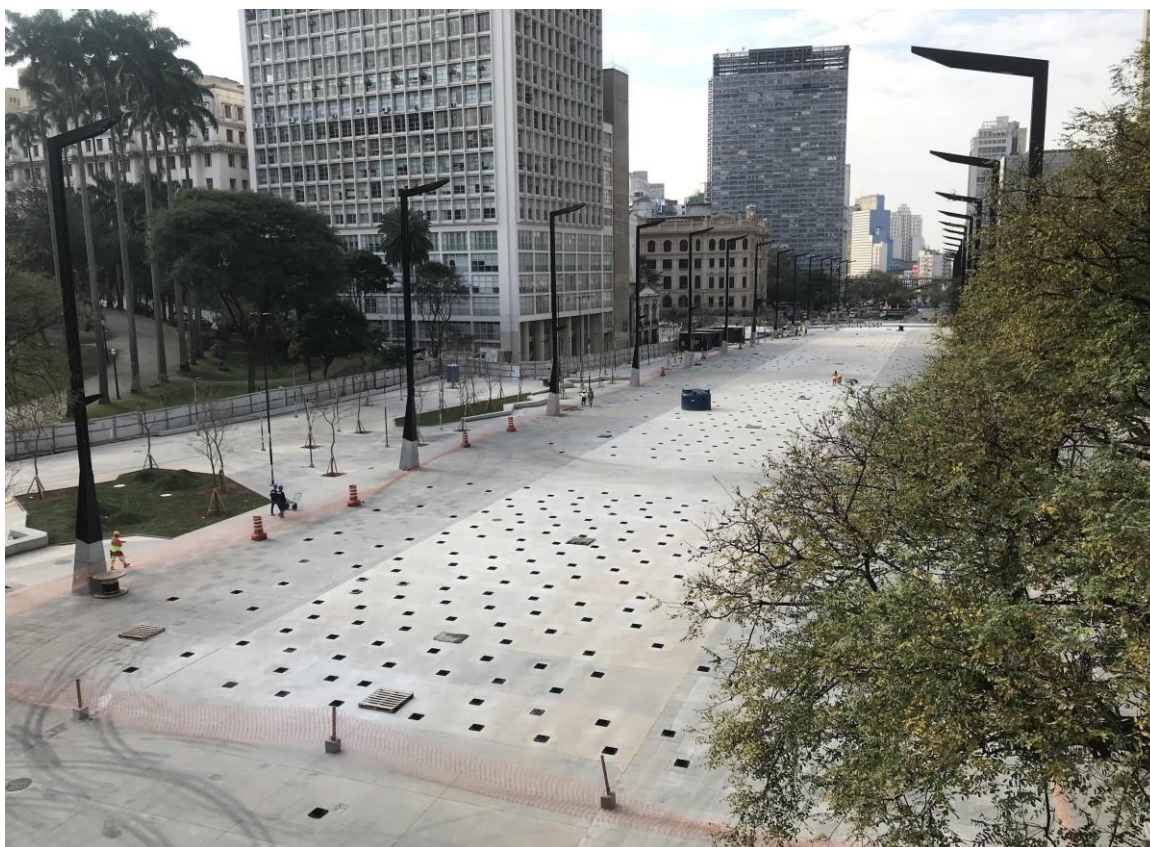
Imagem 47: Obras quase prontas. Foto da autora, julho de 2020.
