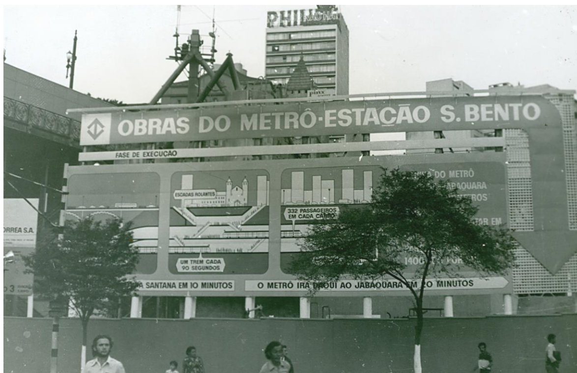
Imagem 35: Estação São Bento: Início das obras. Metrô de São Paulo, maio de 1973.
