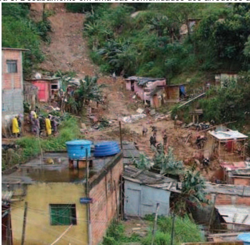
Figura 3: Desabamento em uma das comunidades dos arredores da escola
