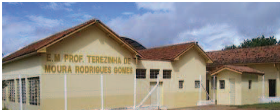
Fachada das Escolas.
