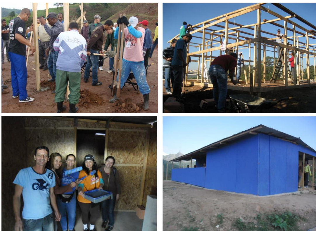
Fotos 59 a 62 – Mutirão da construção da casa do caseiro do Movimento Noroeste (2012)
