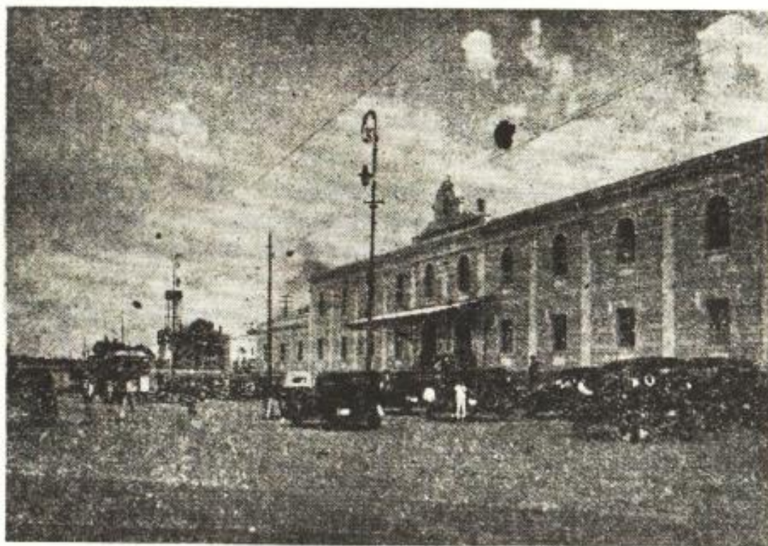
Fachada da Estação da Companhia Paulista
