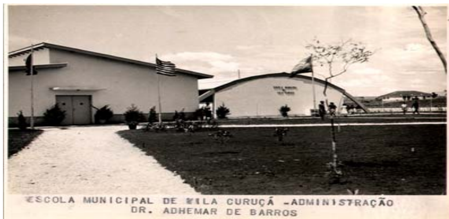
Figura 21 - Escola Municipal de Vila Curuçá (1958)
