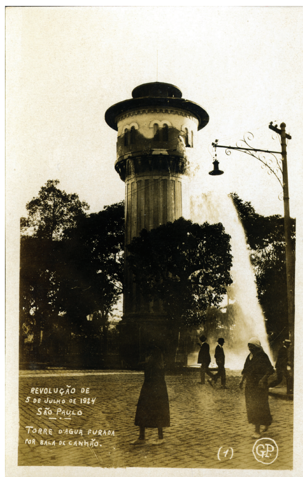
Figura 48: Gustavo Prugner, Torre d'água furada por bala de canhão , São Paulo, 1924.
