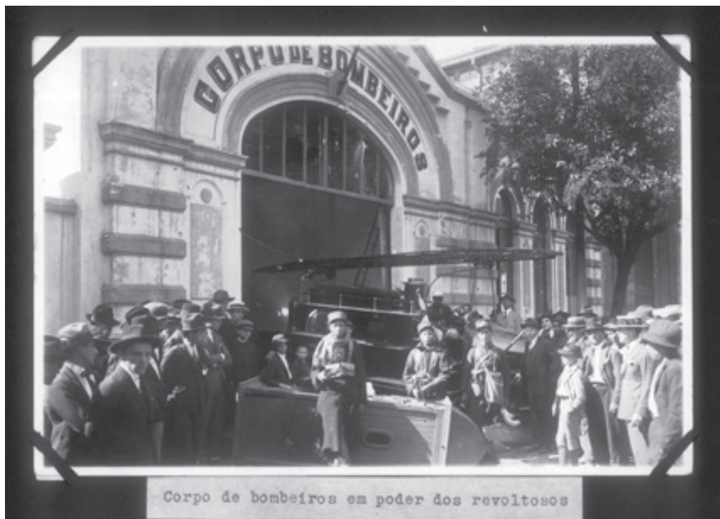
Figura 39: Autoria desconhecida, Corpo de Bombeiros em poder dos revoltosos , São Paulo, 1924.
