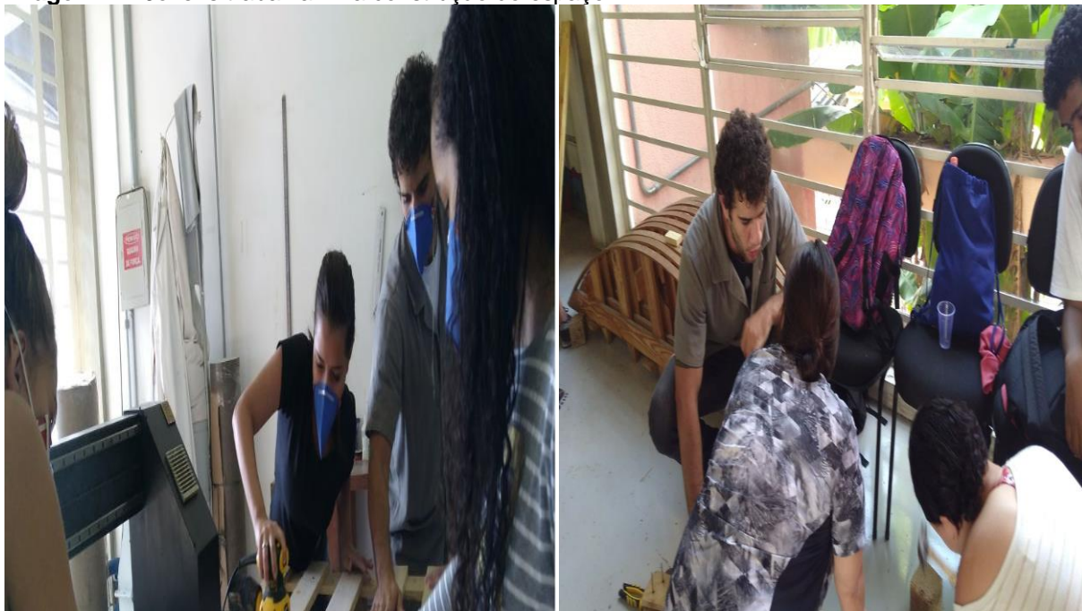
Imagem 11: Jovens trabalham na construção do espaço
