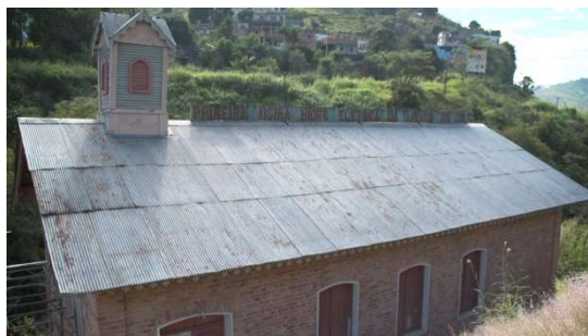
Figura 16. Visão geral da usina Fonte: LMD/Facom
