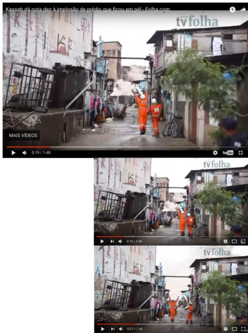
Figuras 1 a 3: Montagem com frames do vídeo: Kassab dá nota dez à implosão de prédio que ficou em pé! - Folha.com (Fonte: TV Folha) 6
