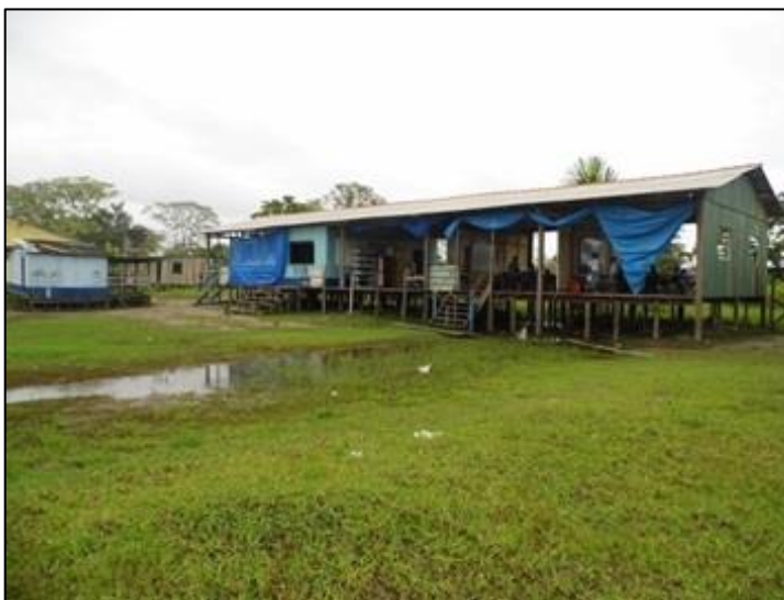
Figura 25 – Escola funcionando em um barracão, situada em área de várzea
