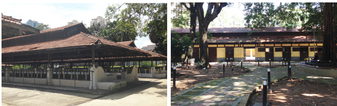
Figuras 10 e 11 – Edificações das baias e cocheiras tombadas pelo CONDEPHAAT, até hoje utilizadas para atividades relacionadas à equitação, entre outras (fotos da autora, 2017).
