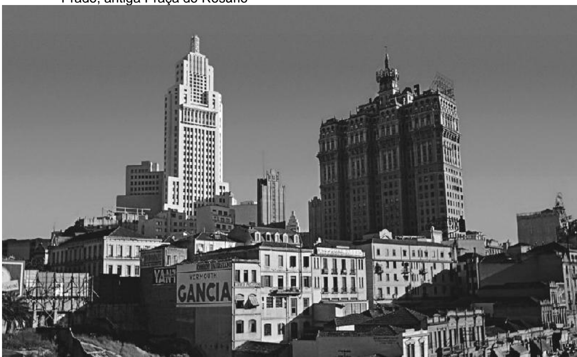
Figura 28 - Os edifícios Altino Arantes (esq.) e Martinelli (dir.) nas proximidade da Praça Antonio Prado, antiga Praça do Rosário
