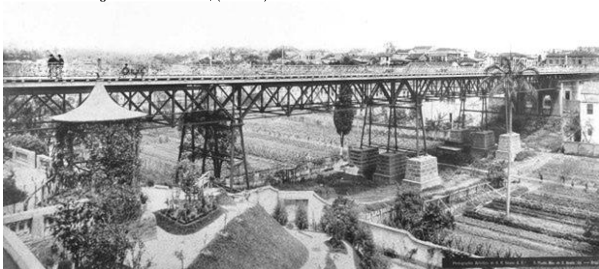
Figura 2 - Viaduto do Chá. Antiga plantação de chá que deu nome ao viaduto sobre o vale do rio Anhangabaú - São Paulo; (c. 1892). Por Qaas.
