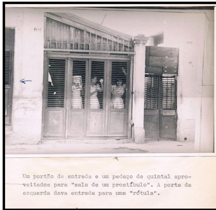
Imagem 6. Prostíbulo na zona confinada no bairro do Bom Retiro. Fotografia: Elvira Aguiar Borges Furlan, 1955
