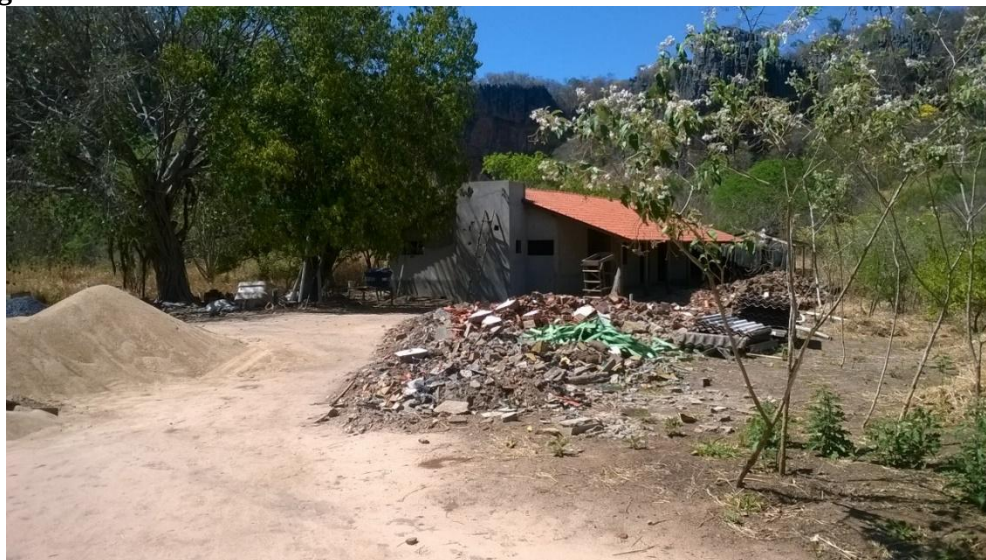
Figura 10: Obras de infraestrutura
