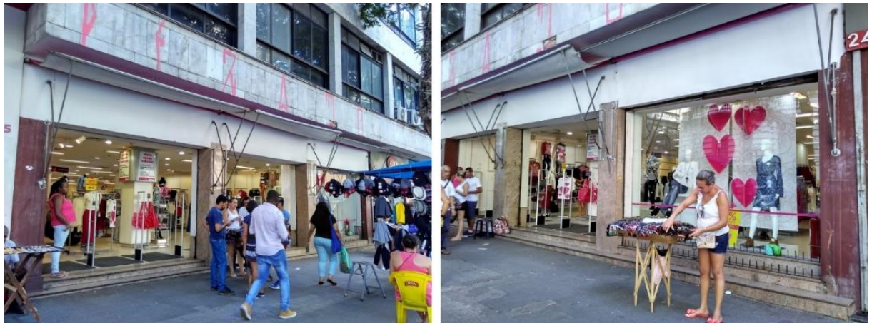
Figura 24: Fachada principal da loja situada no Praça Ramos de Azevedo em São Paulo.
