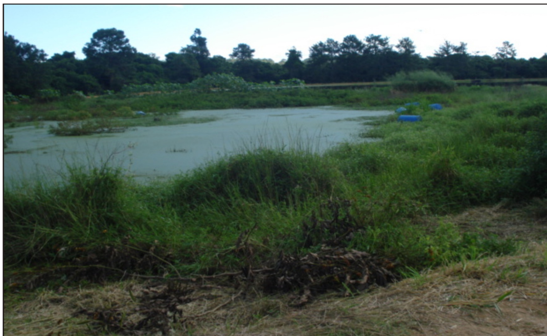
Foto 33: Lagoa anaeróbia desativada em péssimo estado de conservação. FONTE: Acervo pessoal, 2015.
