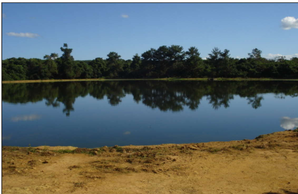
Foto 31: As bordas da lagoa anaeróbia em processo erosivo. FONTE: Acervo pessoal, 2015.
