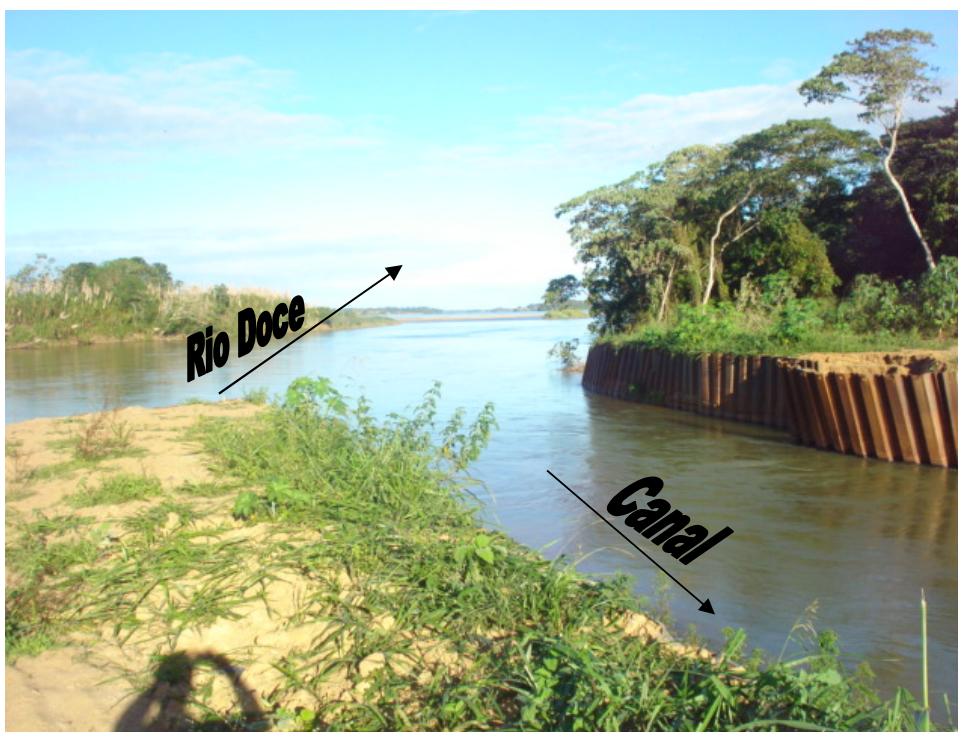
Foto 24: Desvio da água do Rio Doce para a Bacia do Rio Riacho. FONTE: Acervo pessoal.
