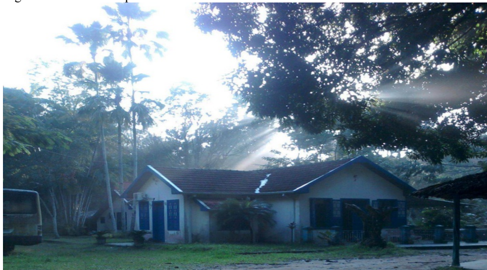
Figura 4 – Fachada do prédio do CRAS Aurá.
