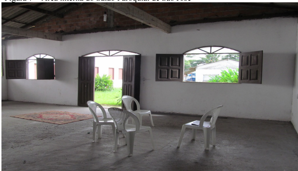
Figura 7 – Área interna do Salão Paroquial de São José
