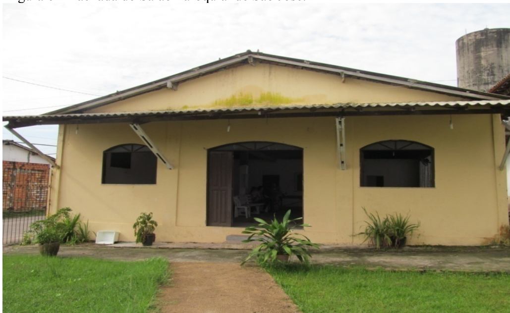
Figura 6 – Fachada do Salão Paroquial de São José.
