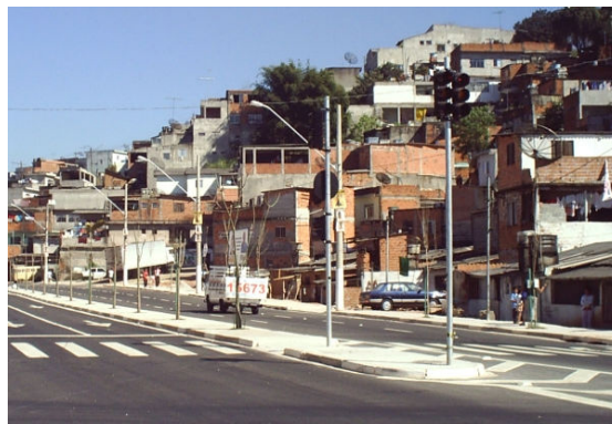
FIGURA 8 - Favela Vera Cruz Durante as Obras de Urbanização
