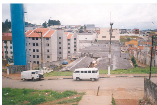
FIGURA 49 - Jupiter- Construção de Prédios e Desmanche dos Alojamentos
