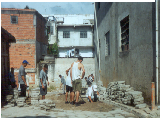
FIGURA 5 - Mutirão de abertura de via com bloquetes
