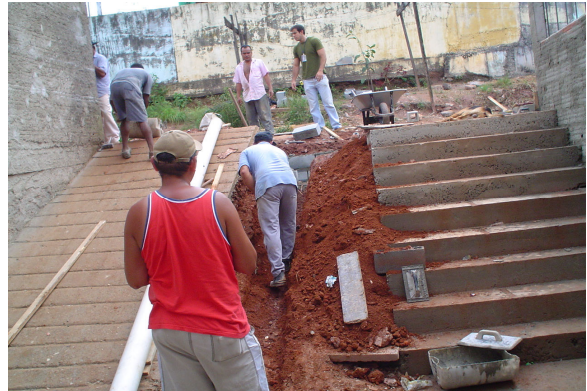
FIGURA 6 - Mutirão para construção de escadaria e rampa
