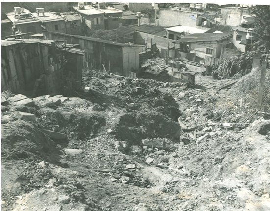
FIGURA 17 - NH Canhema: Abertura de Viário e Realocação de Barracos
