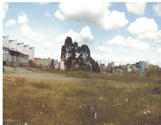
FIGURA 44 - Desapropriação da Área e Aprovação do Projeto do Conjunto Habitacional Jardim Nordeste
