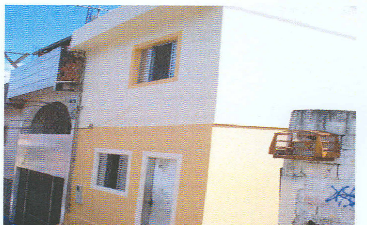
FIGURA 22 - NH Favela do Padre: Primeira Área a Concretizar Negociação de Compra com Proprietário, com Intermédio do SRF
