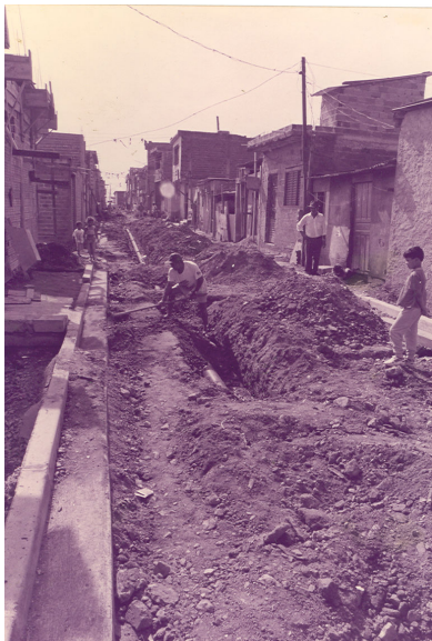
FIGURA 19 - NH Itália: Mutirão de Drenagem e Esgoto
