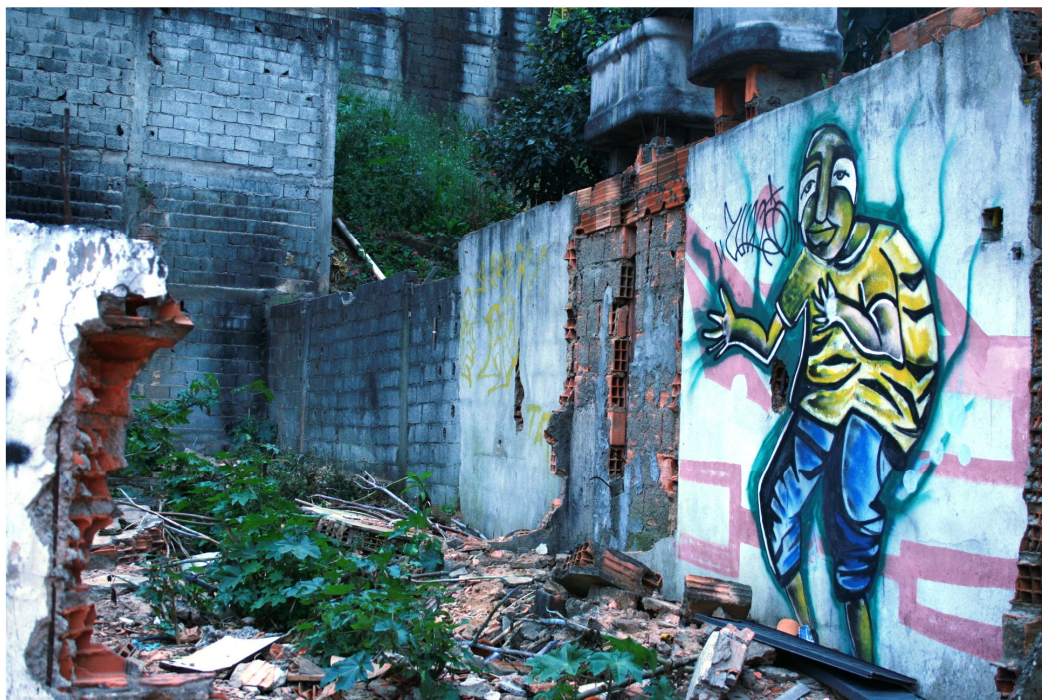
Situação do terreno do “Becos e Vuelas” antes do mutirão de limpeza
