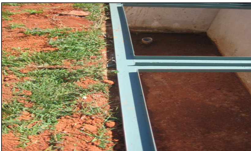
Figura 8 - 3.1.1.1 – Foto da caixa de alvenaria. Fonte: FITO (2009).
