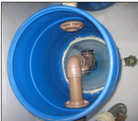
Figura 14 - 3.1.1.7 – Decantador. Fonte: FITO (2009).
