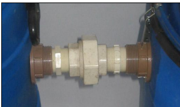
Figura 19 - 3.1.1.12 – União composta. Fonte: FITO (2009).
