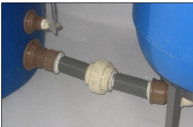
Figura 18 - 3.1.1.11 – Mangote curto. Fonte: FITO (2009).
