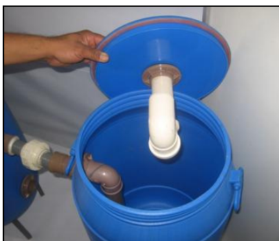
Figura 11 - 3.1.1.4 – Caixa de sabão. Fonte: FITO (2009).
