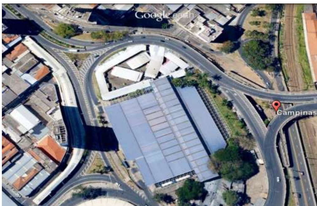
Figura 4: Terminal de Ônibus Central e Viaduto Cury, região central de Campinas-SP (Imagem do Google Earth).
