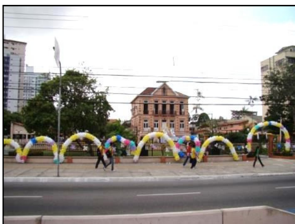
Figura 3 - Prédio do Instituto de Pesquisas Evandro Chagas ornamentado à espera da passagem da romaria.
