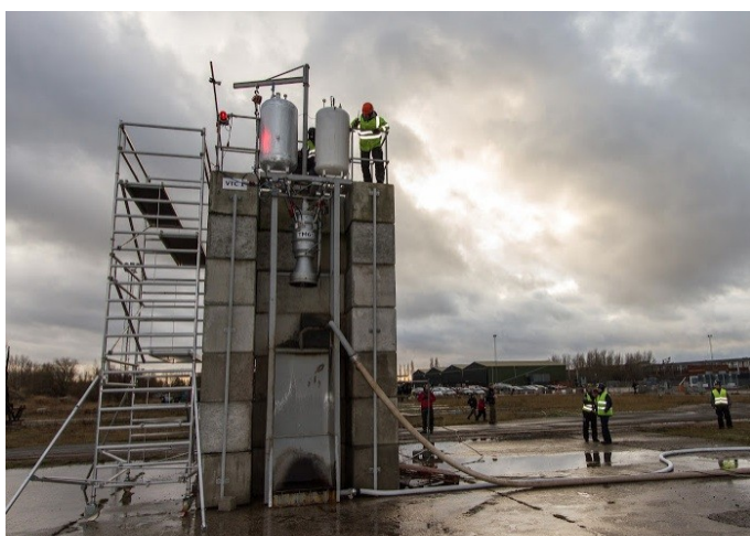
Construção da base de testes de lançamento de foguetes do projeto Copenhagen Suborbitals. Foto extraída do seu site de fotos: https://picasaweb.google.com/114657365514543526210/30122012TM653rdTest?noredirect=1#5827831844053550226
