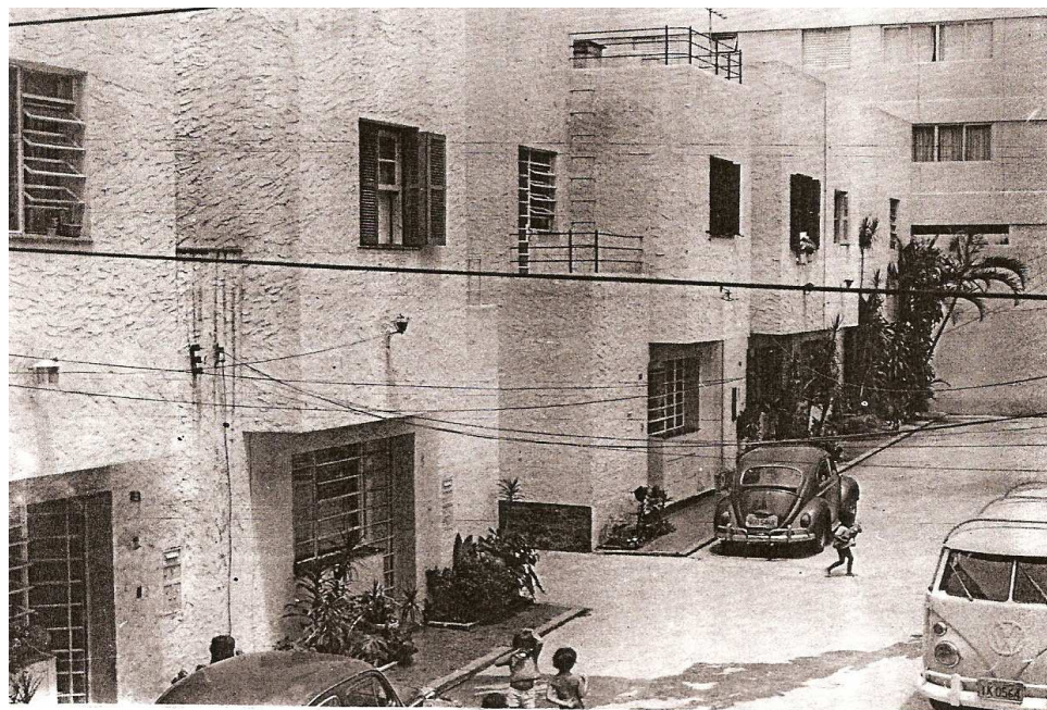
64- Conjunto de casas da Alameda Lorena – vista dos fundos, 1938 Fonte: DAHER, 1979, anexo XXXV.
