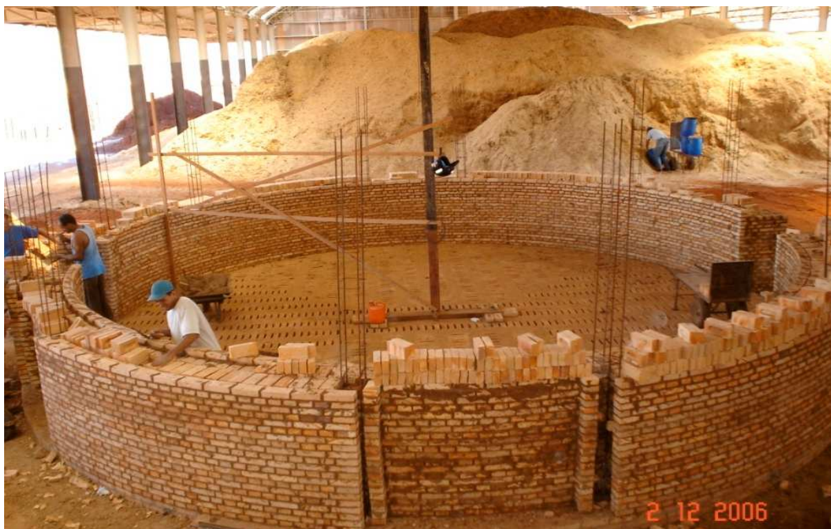
Foto 26. Último patamar do forno: o crivo , o chão vazado. Autor: Roberto Massei. Fonte: Acervo Adilson Monteiro. Data: 2 dez. 2006.
