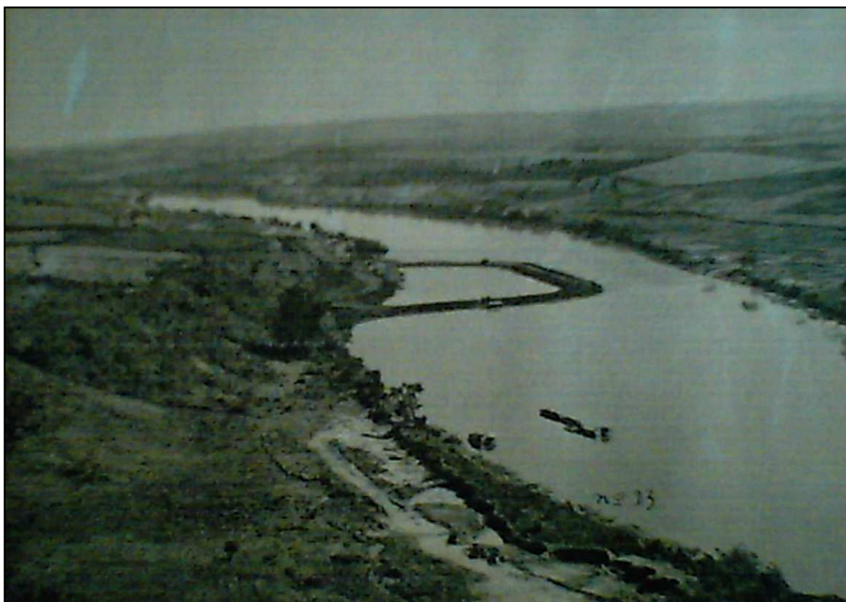
Foto 8. Ensecadeira usada para a construção do eixo da barragem da UHE Barra Bonita. Autor: Oswaldo Grossi. Fonte: Acervo Museu Histórico Municipal Luiz Saffi. Ano: 1958.
