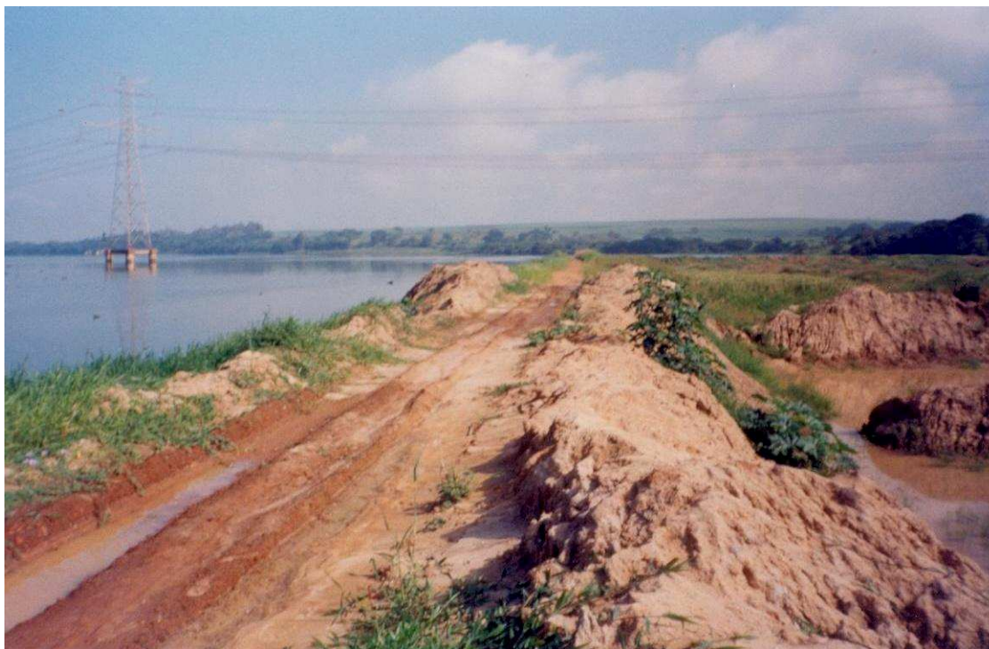
Foto 7. Ensecadeira recente. À esquerda vê-se o rio; à direita nota-se a área seca, de onde se
