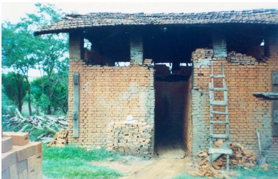
Foto 18. Forno caipira. Hoje ele é usado para queimar tijolo comum. Até a década de 1950 era utilizado para queimar telha. Autor: Roberto Massei. Fonte: Acervo do autor. Data: nov. 2000.
