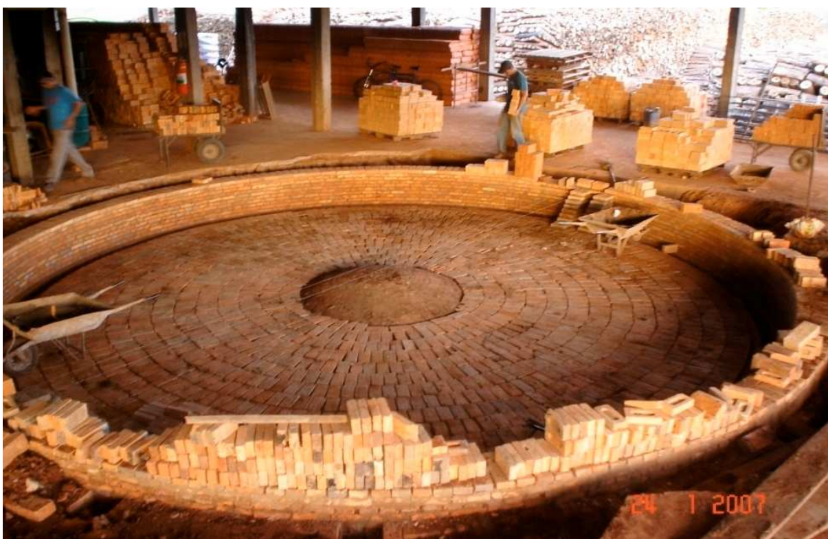
Foto 23. Piso sobre os oito canais. A abobrinha já está fechada. Sobre este piso serão colocadas as banquetas . Autor: Adilson Monteiro. Fonte: Acervo Adilson Monteiro. Data: 24 jan. 2007.
