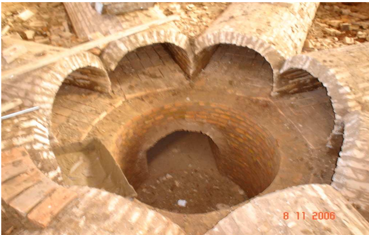
Foto 14: Parte subterrânea de um forno abobrinha . No centro está o poço que dará origem à abobrinha . O canal, no centro, leva à chaminé. Em primeiro plano, estão os oito canais. Eles serão fechados com um novo piso. Autor: Adilson Monteiro. Fonte: Acervo Adilson Monteiro. Data: 8 nov. 2006.
