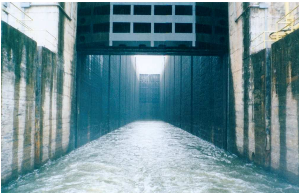
Foto 11. Entrada da eclusa de Barra Bonita. A passagem por ela faz parte do passeio de barco pelo rio e pela represa, a montante da usina. É o turismo fluvial. Autor: Roberto Massei. Fonte: Acervo do autor. Data: 15 out. 2004.
