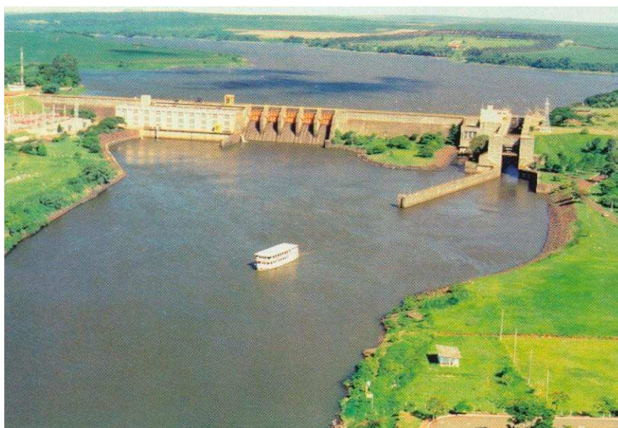
Foto 1. Vista aérea da UHE Barra Bonita. Fonte: Prospecto AES Tietê. Energia limpa, confiável e segura , [p. 1]. S/ID.
