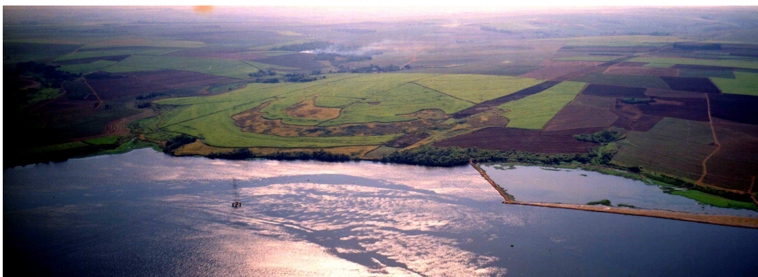
Foto 6. À esquerda da fotografia observa-se a linha de transmissão. O croqui da ensecadeira da p. 136 refere-se a esta área. A próxima fotografia foi tirada dentro da ensecadeira, quase no meio do rio. Autor: S/I/A. Fonte: Arquivo AES Tietê. Ano: [2000].
