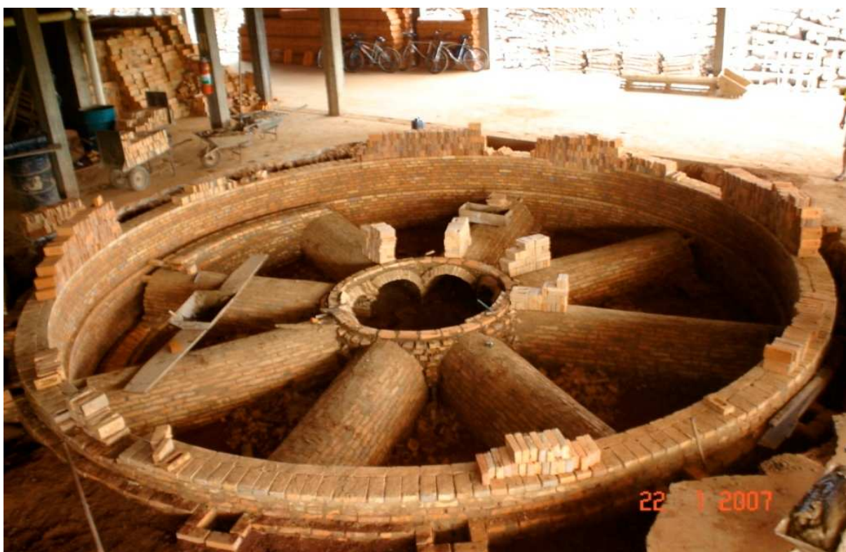
Foto 22. Fotografia geral do forno abóbada abobrinha . No primeiro plano, os oito canais que terminam no poço , na abobrinha . O calor chega ao poço e vai para a chaminé. Autor: Adilson Monteiro. Fonte: Acervo Adilson Monteiro. Data: 22 jan. 2007.
