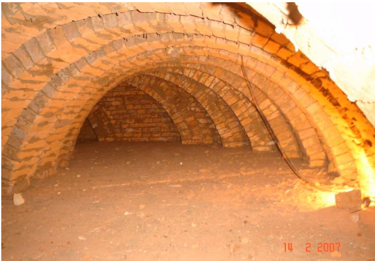
Foto 19. Arco do forno abóbada salão em construção. É por este grande canal que o calor circula. Autor: Roberto Massei. Fonte: Acervo Adilson Monteiro. Data: 14 fev. 2007.
