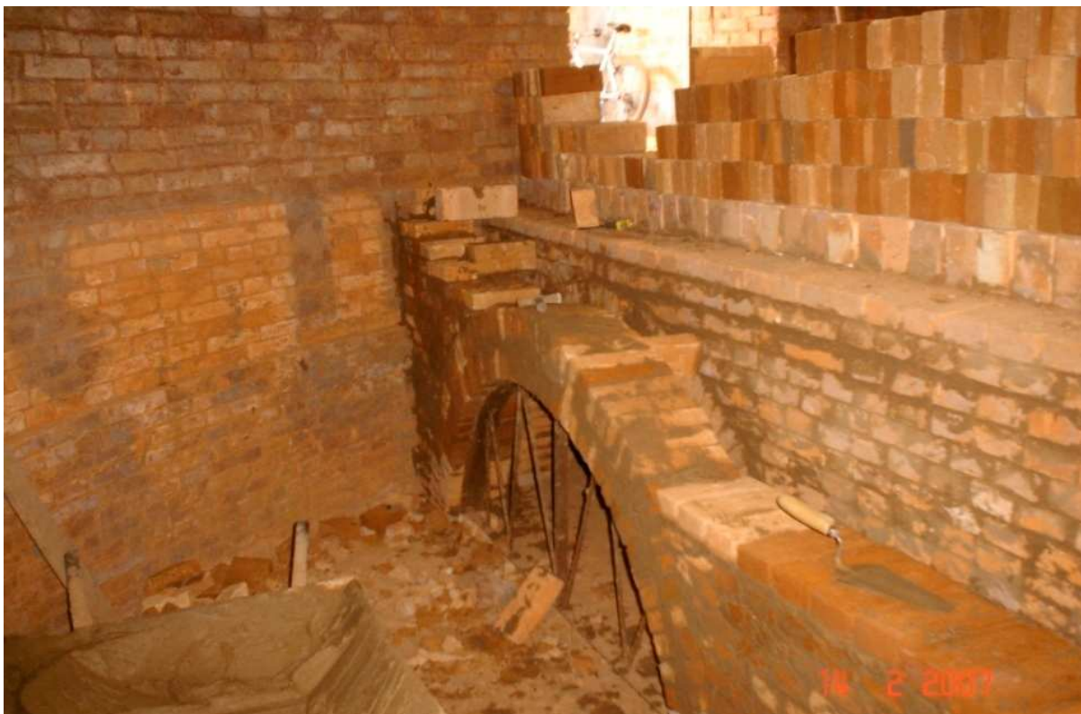
Foto 20. A abertura do canal do forno salão ainda está com a zimbra (molde). Uma parede acompanha cada arco, de um lado ao outro. Autor: Roberto Massei. Fonte: Acervo Adilson Monteiro. Data: 14 fev. 2007.
