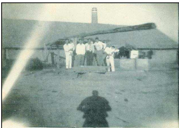
Foto 30. Amassadora movida a burro usada para a produção de telhas e tijolos antes da mecanização das cerâmicas. S/I/A. Fonte: Acervo Argemiro Blazissa. S/I/D.
