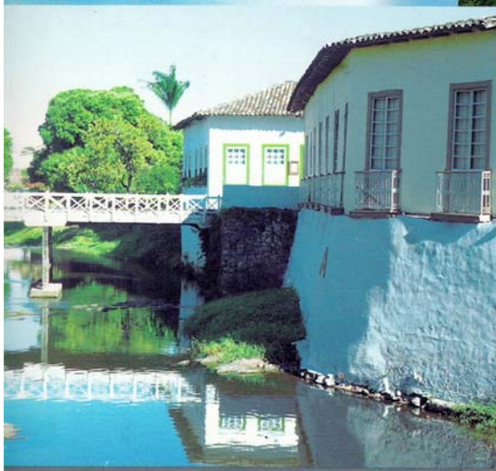
Ponte Rua Moretti Fogia
