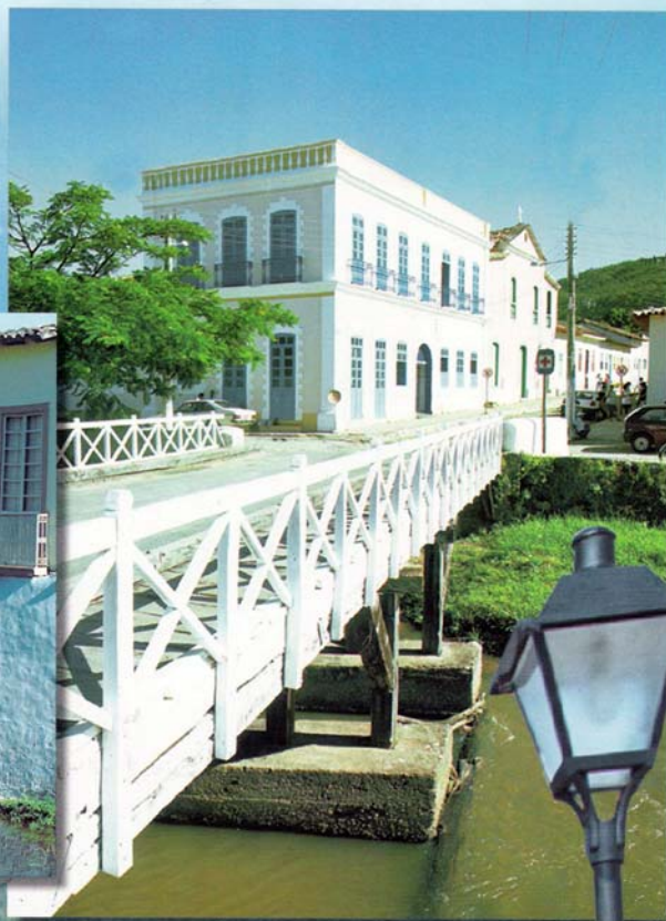
Ponte Rua Couto Magalhães
