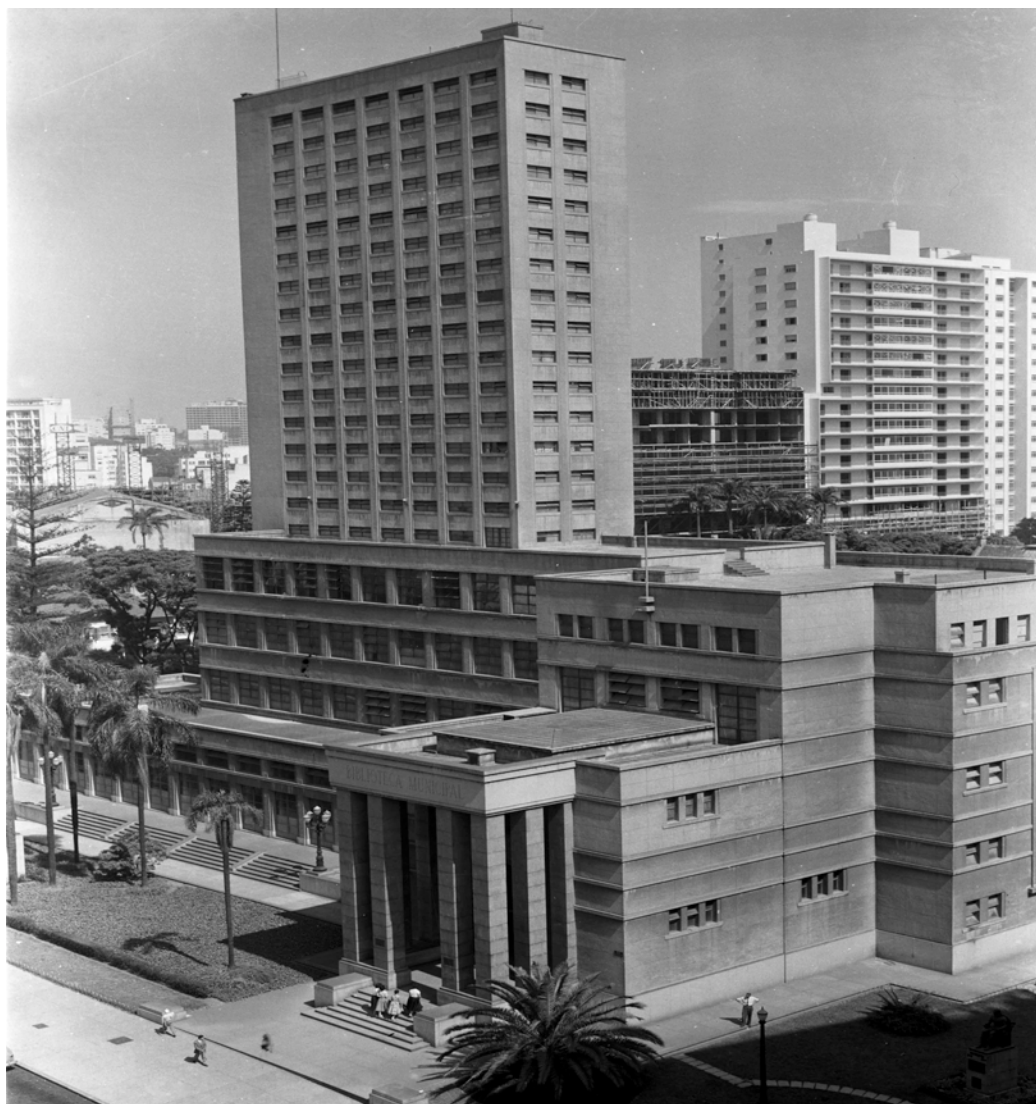
Figura 1 – Tomada geral da parte frontal da Biblioteca Municipal Mário de Andrade, 1952.
