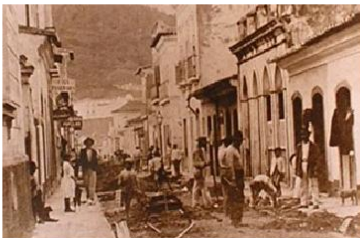
Imagem 11: Detalhe das obras na Rua João Pinto.
