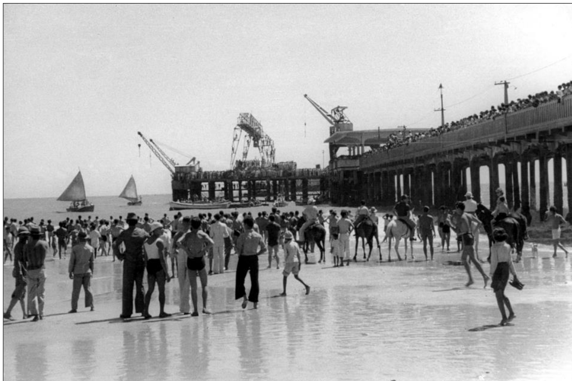
Ilustração 9: Construção da Ponte Metálica na Praia de Iracema, meados dos anos de 1920. Fonte: Acervo de Maria de Fátima Garcia.
