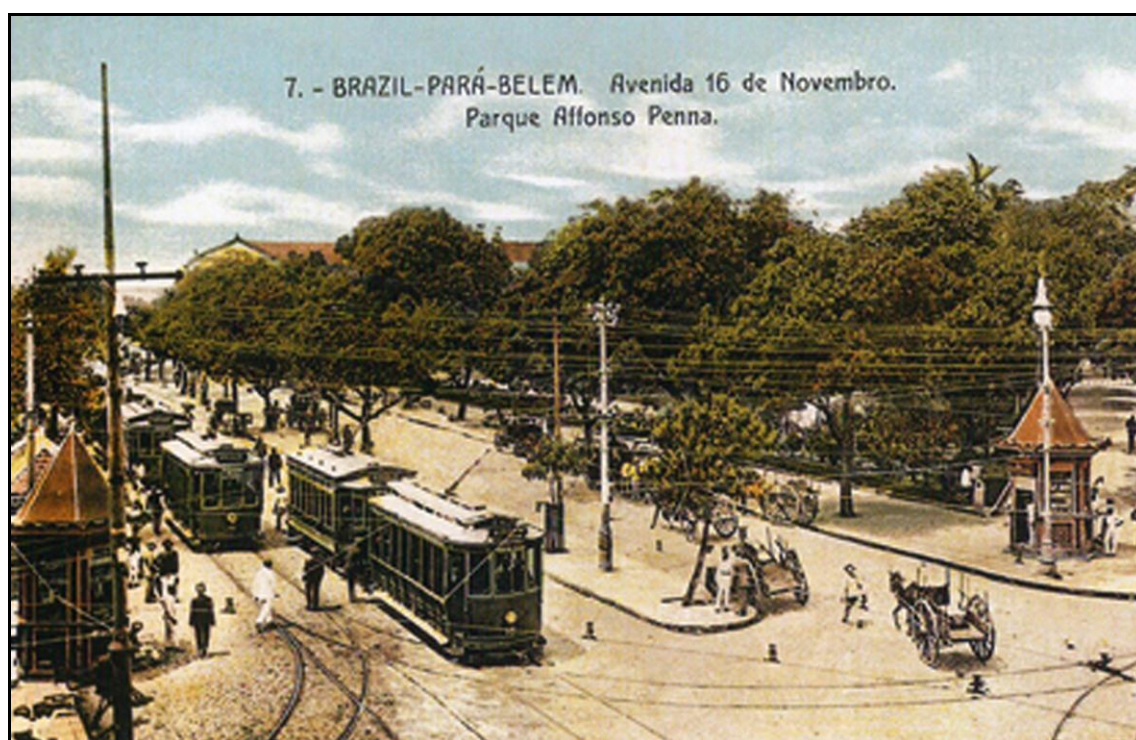
Figura 196 Fotografia – Avenida 16 de Novembro. Fonte: João Emílio Gerodetti e Carlos Cornejo (2004).
