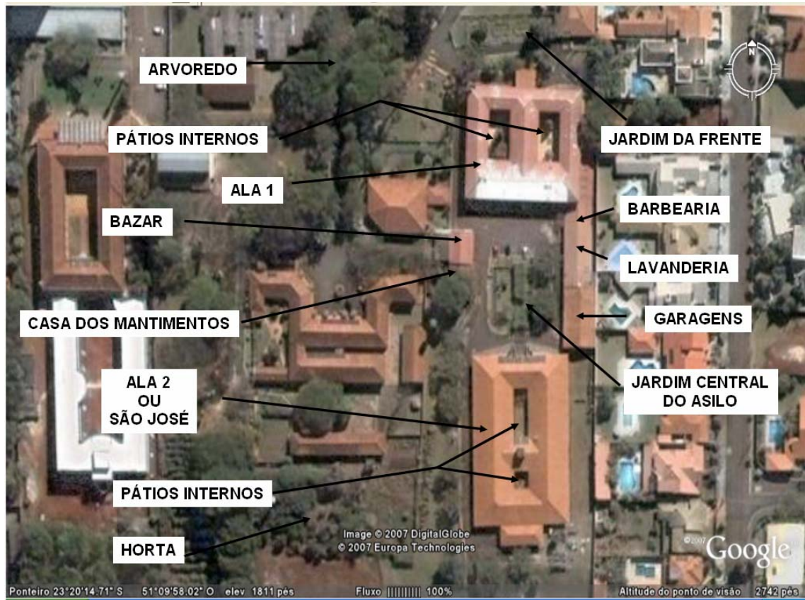
Figura 3 - Vista aérea do Asilo São Vicente de Paulo.
