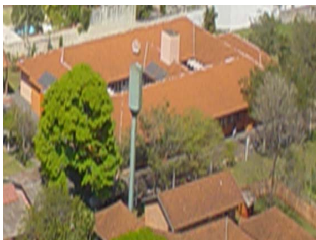
Figura 29 - Vista da Ala 2 (enfermaria).
