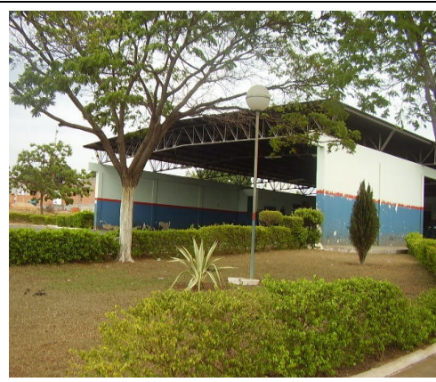
Figura 4: Terminal Rodoviário Autora: FONSECA, G. S, 2007.
