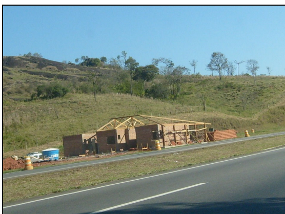
Figura 24: construção de base operacional Fonte: Fonseca, 2008
