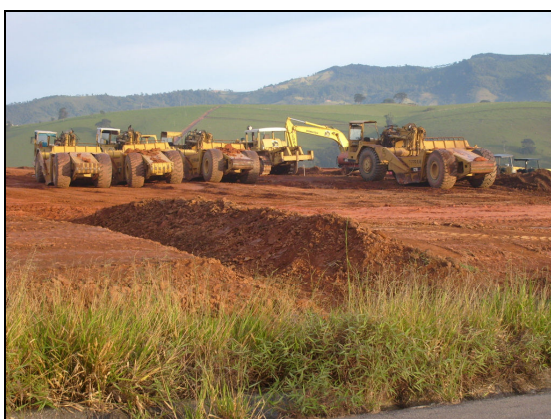
Figura 29: Tratores preparando o terreno Fonte: FONSECA, 2008
