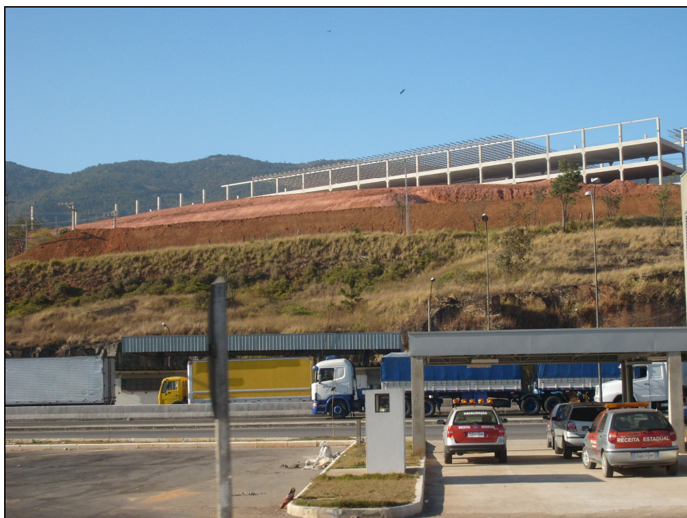
Figura 28: Obras para a instalação da fábrica da Centauro; proximidade da Rodovias Fernão Dias Fonte: FONSECA, 2008
