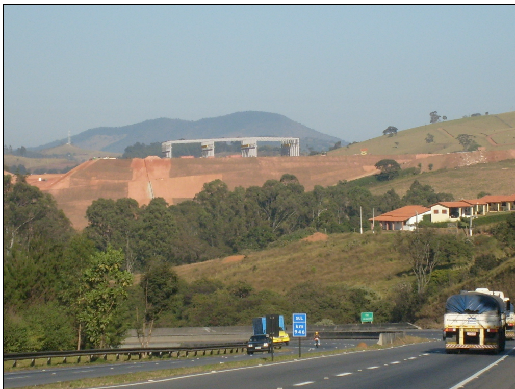
Figura 26: Ao fundo obras de terraplenagem da Medabill; próxima da Rodovia Fernão Dias Fonte: FONSECA, 2008
