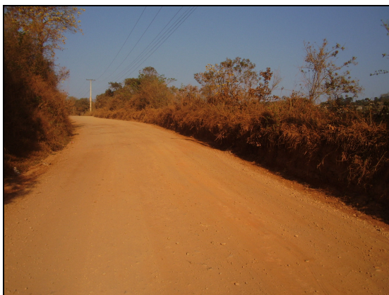
Figura 33: estrada rural antes de obras Fonte: FONSECA, 2007
