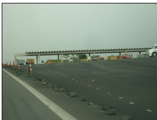
Figura 25: construção de Praça de Pedágio Fonte: Fonseca, 2008
