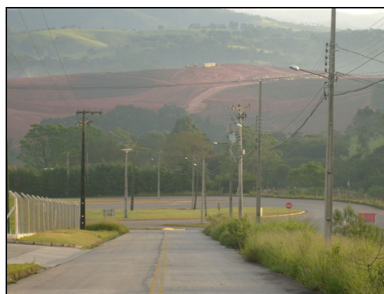
Figura 30: Obras em Distrito Industrial Fonte: FONSECA, 2008
