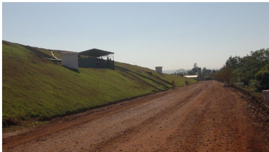
Foto 7 - Sistema de coleta de gases CGR-Guatapar
