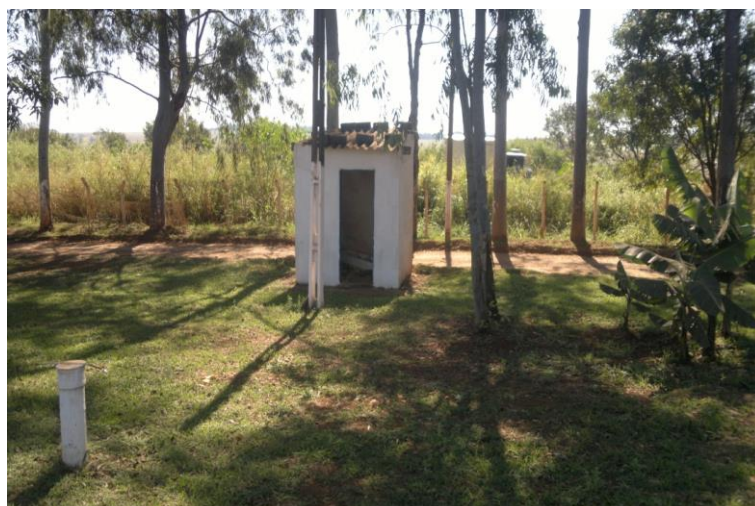
Foto 2 - Poço artesiano para averiguação da contaminação da água subterrânea
