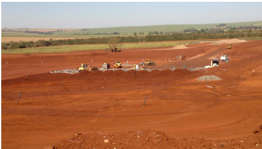
Foto 6 - Vista geral do aterro sanitrio CGR-Guatapar
