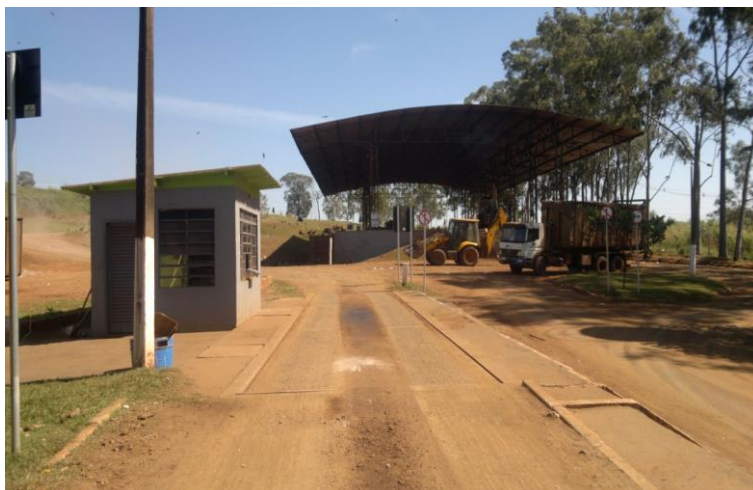
Foto 5 - Vista geral da área de transbordo, em primeiro plano a área de pesagem
