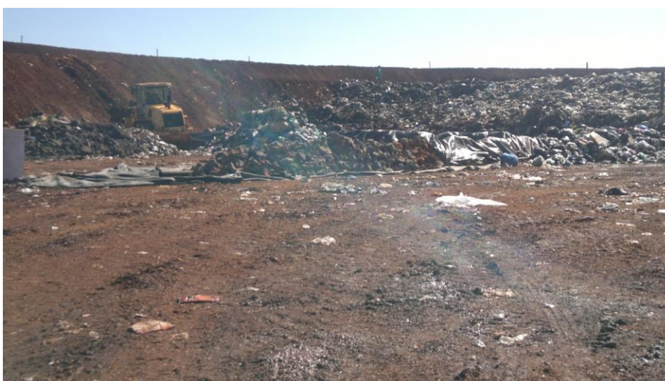
Foto 10 - Trator compactando os resíduos em uma célula. CGR-Guatapar
