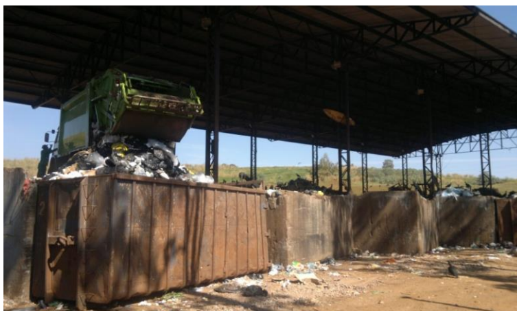
Foto 4 - Caminhão descarregando resíduos sólidos em caçambas
